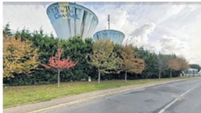
L'agglomération Dieppe-Martin-Église poursuit son aménagement de la zone Eurochannel. (© Capture d'écran Google Maps)
